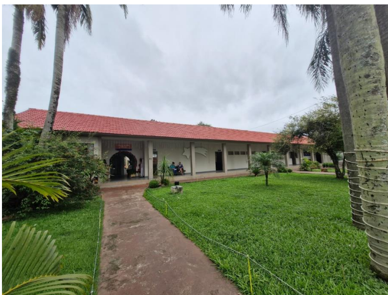
Figura 1 – Reforma e manutenção do telhado finalizada
