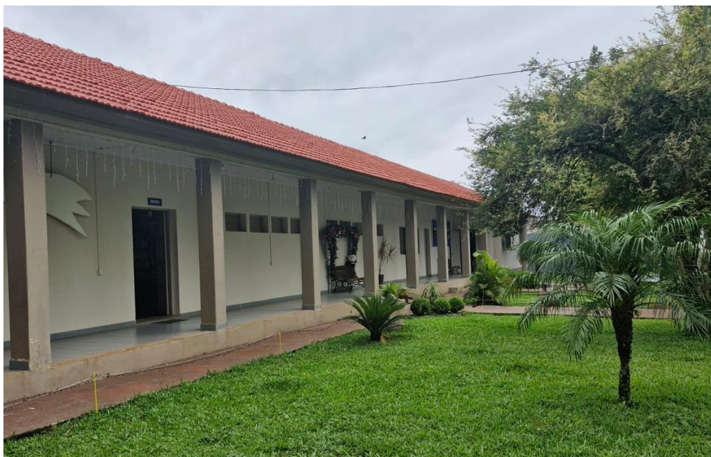
Figura 3 - Reforma e manutenção do telhado finalizada
